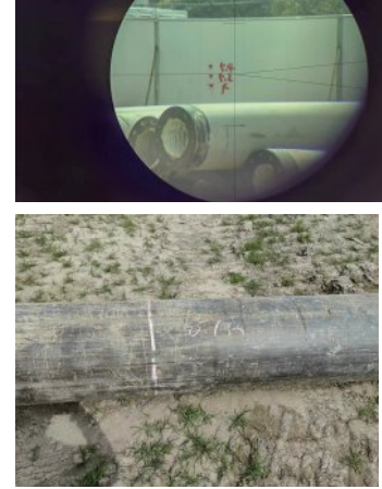
图18-19:对送桩标高进行复查核
