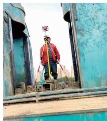
图3:利用全站仪对桩位进行复核
