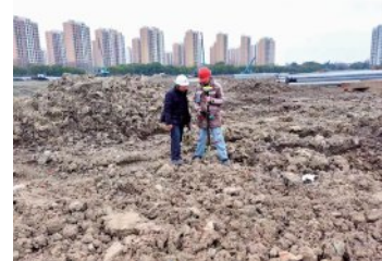
图2:对场地内的桩位点进行校对(总包、监理、分包三方校对)
