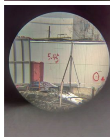
图9:利用水平尺校准桩身垂直度
