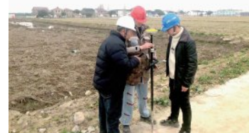
图1:对建设单位提供的控制点进行核对
