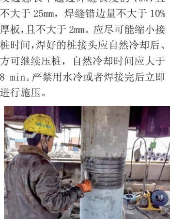
图14-15:桩头对接,桩头清理
