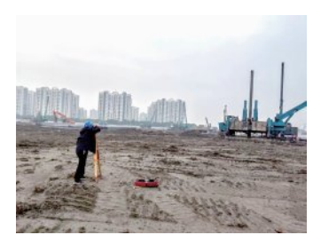
图8:利用经纬仪复核桩身垂直度
