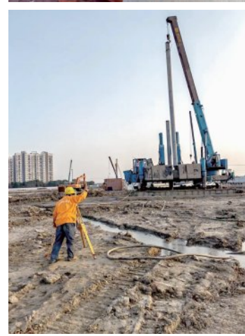
图12-13:打桩过程中校准桩身垂直度
