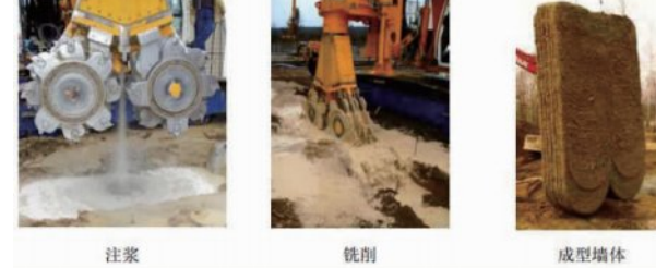
注浆 铣削 成型墙体 实际效果和最终成型墙体
