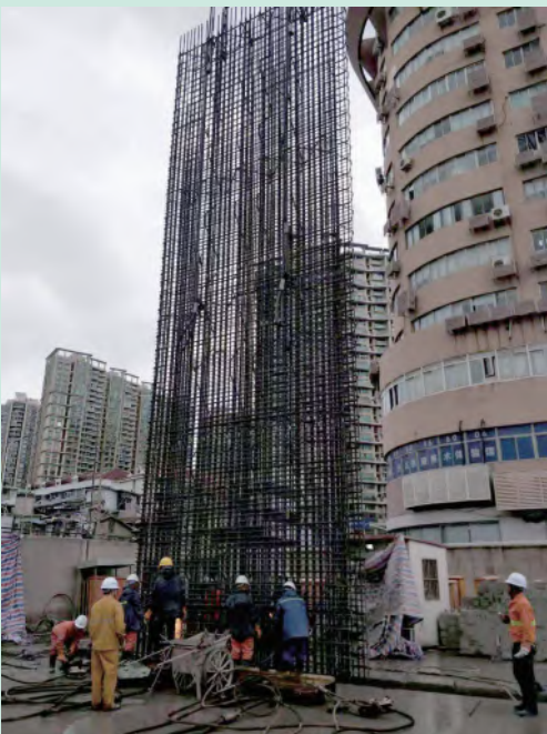
A67 钢筋笼入槽
